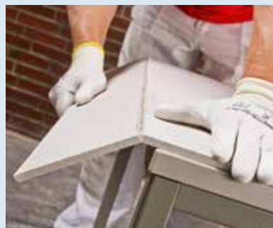
▲ 2. Zuschneiden Kellersanierplatte ritzen und brechen
