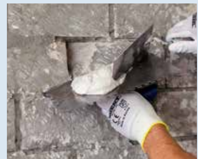
▲ 2. Verfüllen Verfüllen von Rissen und Ausbrüchen an Wänden
