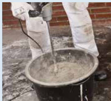
▲ 1. Anmischen Einstellen der gewünschten Konsistenz durch Wasserzugabe
