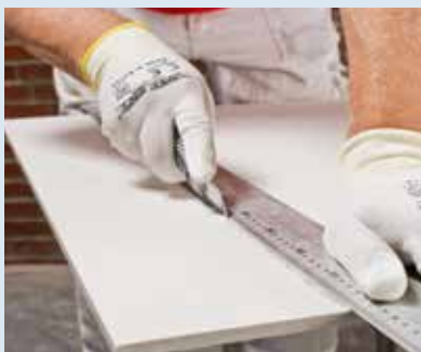
▲ 1. Ausmessen Kellersanierplatte ausmessen
