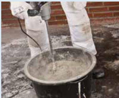
▲ 1. Anmischen Entfeuchtungsputz anrühren
