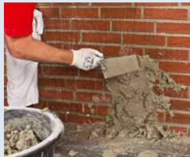
▲ 2. Auftragen Entfeuchtungsputz anwerfen
