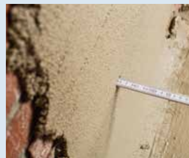
▲ 5. Messen Kontrolle der Schichtdicke
