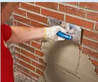
▲ 4. Glätten Entfeuchtungsputz glätten
