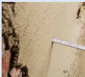
▲ 5. Messen Kontrolle der Schichtdicke
