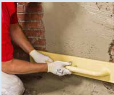
▲ 4. Glätten Sperrputz glätten oder filzen
