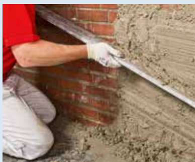
▲ 3. Abziehen Sperrputz abziehen
