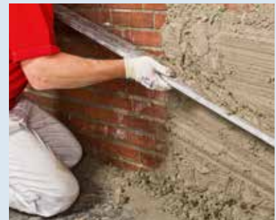
▲ 3. Abziehen Entfeuchtungsputz abziehen
